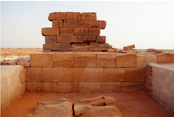
Abb. 4: Amuntempel Raum 107, nach der Restaurierung, © Naga-Projekt.
