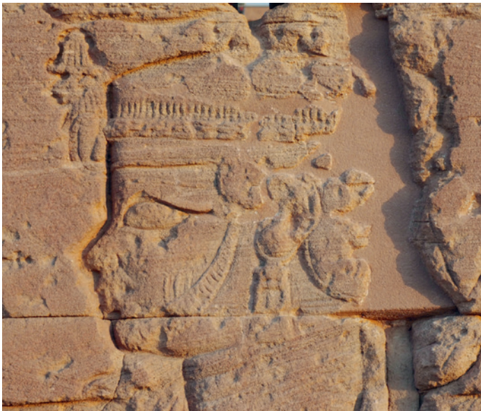
Abb. 24: Löwentempel, Außenwand Westseite, nach der Restaurierung, © Naga-Projekt.
