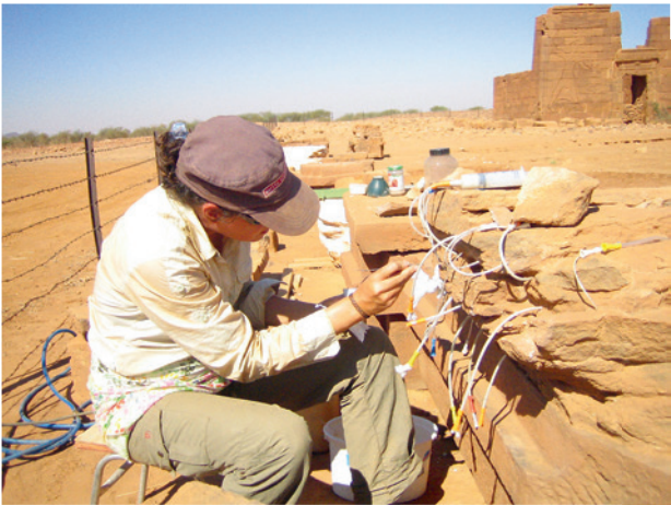
Abb. 12: Ines Seiffert bei der Injektion von mineralischem Mörtel an Rissen eines Sandsteinblocks, © Naga-Projekt.
