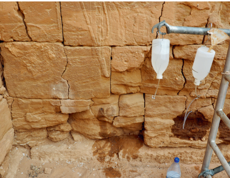
Abb. 20: Löwentempel Naga, Stabilisieren des Sandsteingefüges durch Festigung mit Kieselsäureester, © Naga-Projekt.
