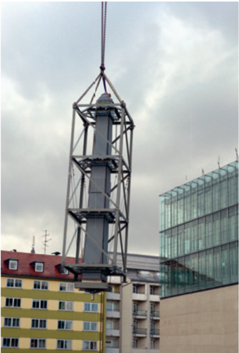
Abb. 12: Obelisk am Haken. Der Obelisk im „Stahlkorsett“ beim Einbringen in den Neubau des Ägyptischen Museums, © SMÄK & Dr. Pfanner GmbH.
